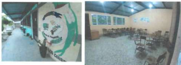
FOTO 1: PINTURA EN MUROS INTERIOR Y EXTERIOR
