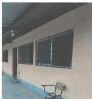
FOTO 3: MANTENIMIENTO DE BARANDAS
